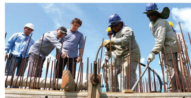
Governador Robinson Faria vistoria obra de concretagem da nova ponte
